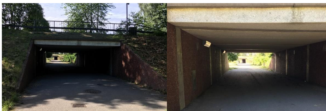
Figur 10. Foton över gång- och cykeltunnlarna under Siriusgatan respektive Bergsjövägen.
